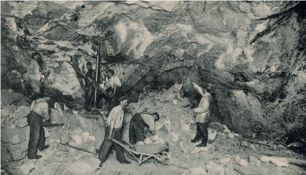
Abb. 6: Abbau im Siderit-Quarz-Gang der Grube „Eisenzecher Zug“ bei Eiserfeld um 1903. Deutlich ist der hohe Anteil an Quarz (weiß) im Siderit (mittelgrau) zu erkennen; dunkle Gesteinspartien sind Nebengestein (Foto: Heinrich Schmeck, Siegen).
